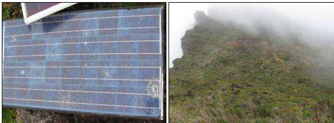
Figura 2.1.134. Estado de los paneles solares en la estación de Cráter (izquierda). Distribución de material volcánico de menor tamaño en el sector de la estación Cráter (derecha).
