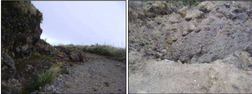
Figura 2.1.123. Efectos identificados en la carretera, en la vía a la cima de Galeras, generados por la erupción del 2 de enero de 2010.
