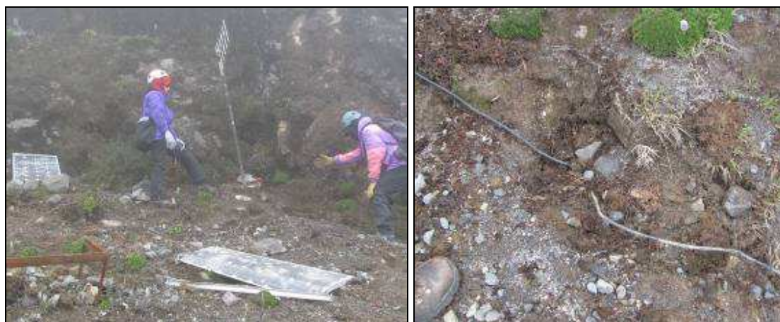
Figura 2.1.131. Daño de paneles solares (izquierda). Impacto de roca sobre el cable de la antena de la estación de Anganoy (derecha).
