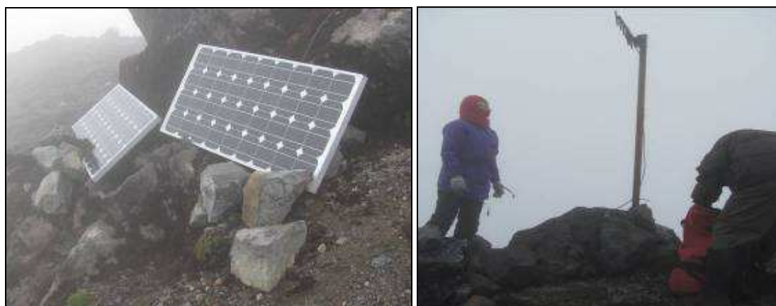
Figura 2.1.133. Estado de los paneles solares de la repetidora de la estación Calabozo (izquierda). Condiciones de funcionamiento de la repetidora de la estación de corto período Calabozo (derecha).
