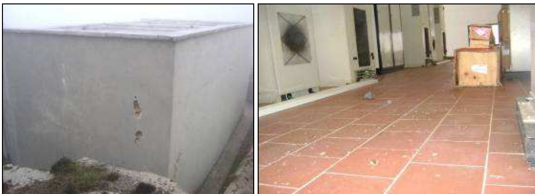
Figura 2.1.125. Efectos de los impactos de roca en la parte externa de las instalaciones, así como en la parte interna de las instalaciones de la empresa de telecomunicaciones.
