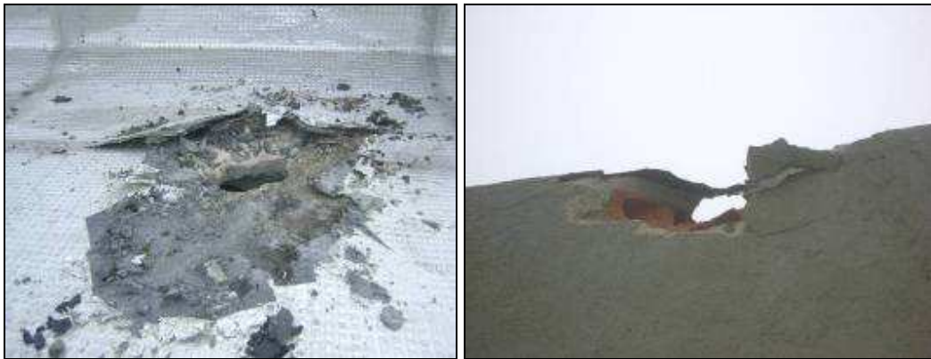
Figura 2.1.124. Efectos en el sector externo de la empresa de telecomunicaciones debido a impactos de roca por la erupción del 2 de enero de 2010.
