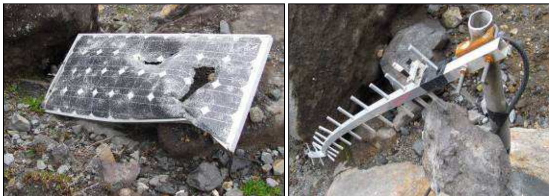
Figura 2.1.132. Daño de panel solar (izquierda). Daño en la antena de transmisión de datos del inclinómetro electrónico Cráter (derecha).
